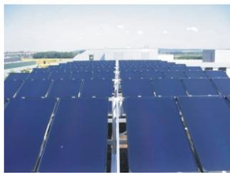
Figura 14 - Campos de colectores para instalação de arrefecimento do Centro de Formação da AUDI em Ingolstadt (1)
