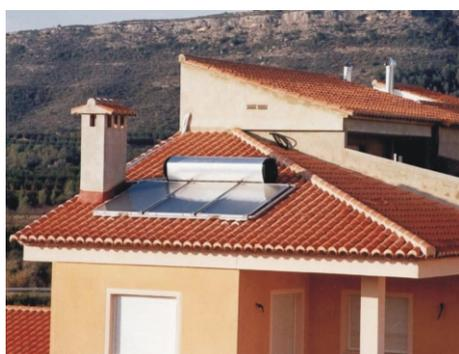
Figura 8 - Aplicação de um sistema termosifão (4)
